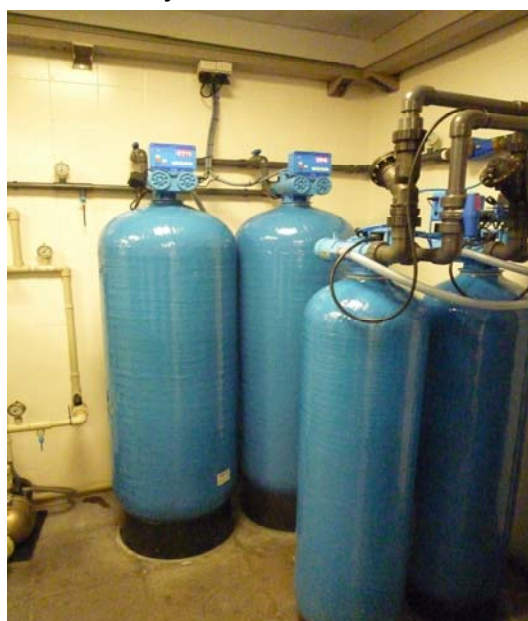
Foto 6.29. y 6.30. Sala de tratamiento de agua: doble ósmosis inversa y sistema de filtrado
