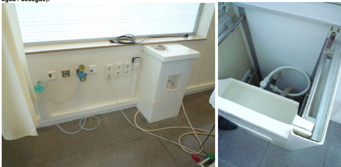
Foto 6.32. y 6.33. Puesto de diálisis: tomas y registro de instalaciones (oxígeno / vacío; electricidad; voz / datos; agua / desagüe).
