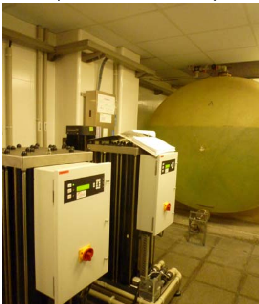
Foto 6.29. y 6.30. Sala de tratamiento de agua: doble ósmosis inversa y sistema de filtrado
